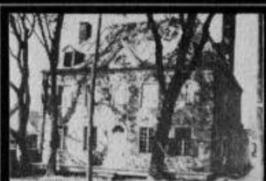
Maison Nicolas Patenaude Travaux de rénovation de la demeure, après incendie, dirigés vers 1840. L'architecte était Auguste Lacroix et le maître d'œuvre, Étienne de LaRoche. Réhabilitée dans son état actuel par Carleton.
